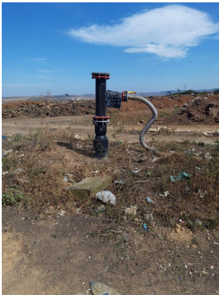
Figura 3 – Capul special de put de gaz, record flexibil inox si conducta transportoare
