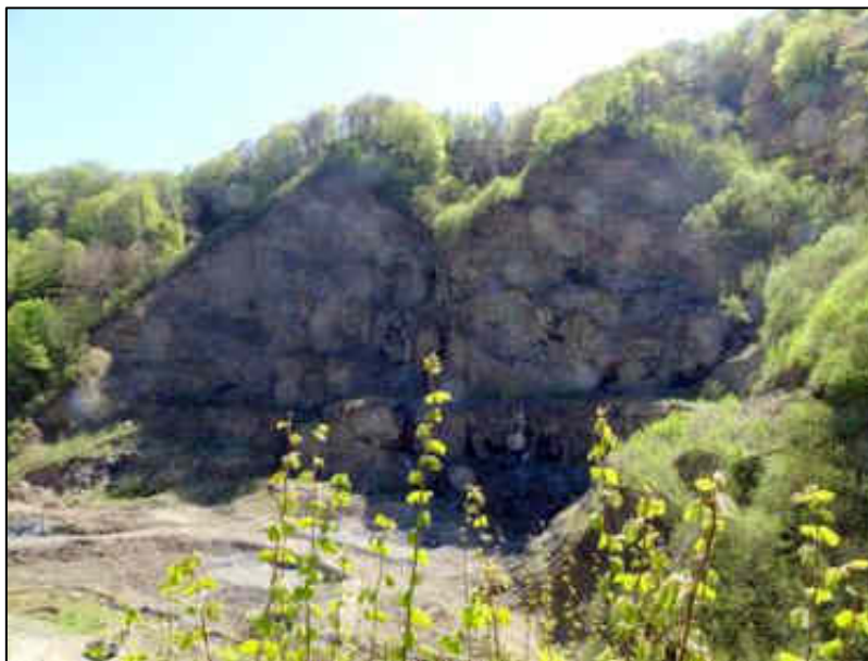
Figura nr. 24 – Aspect privind prezența unei cariere de piatră închise în imediata vecinătate sudică a perimetrului analizat
