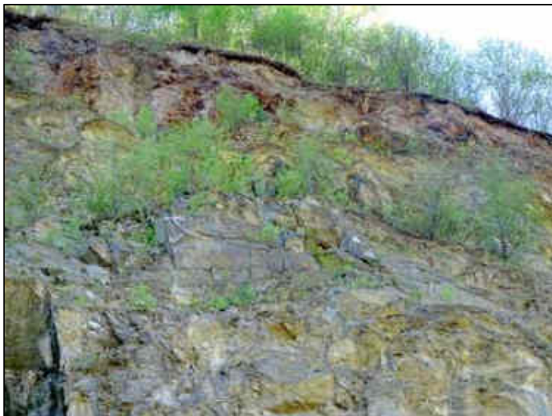
Figura nr. 26 – Aspect privind instalarea pe cale naturală a vegetației lemnoase pe pereții vechii cariere închise, învecinate cu perimetrul analizat (se constată prezența speciei pioniere Betula pendula (mesteacăn))
