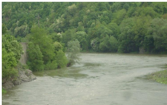
Fig.96. Erodare protectie pe malul drept al raul Olt
