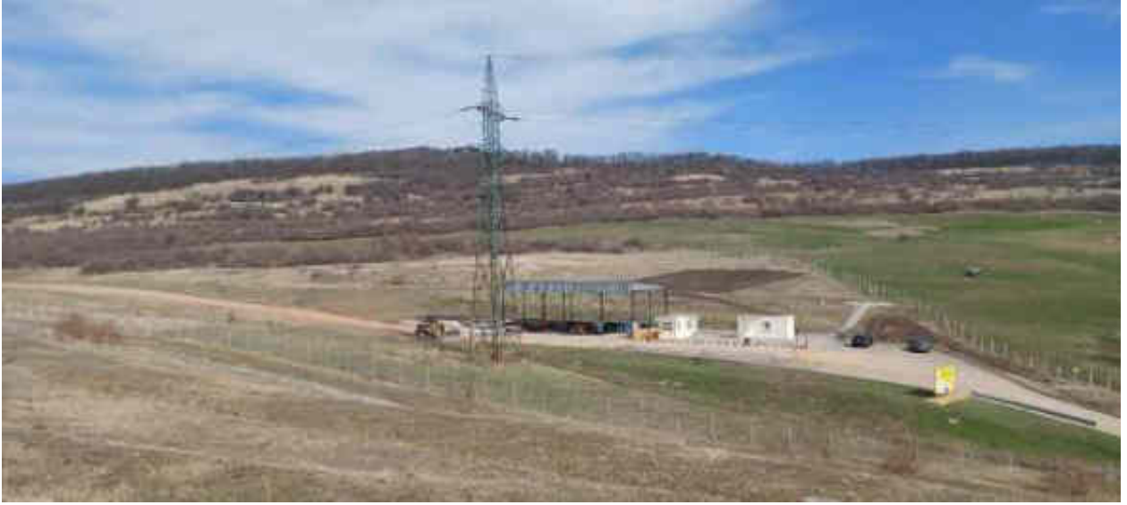
Figura nr. 14 Aspect amplasament vedere spre nord
