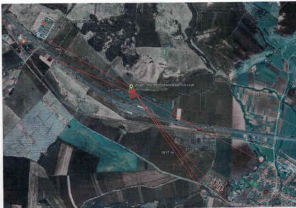
Plan 1 – Distanțe față de zona rezidențială și față de alte obiective de interes Planurile aferente proiectului sunt anexate la prezentul memoriu de prezentare.
