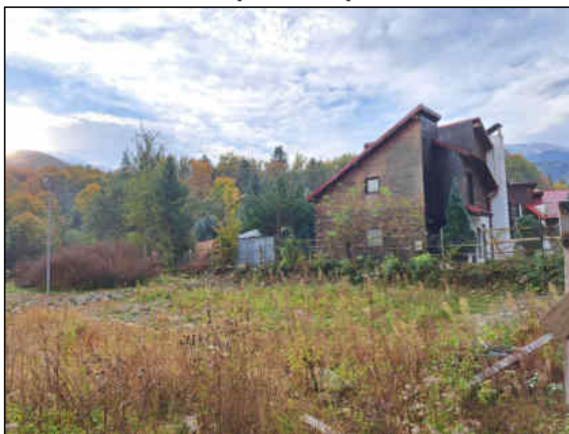
Figura nr. 10 – Aspect privind amplasamentul analizat și o parte construită din vecinătatea acestuia
