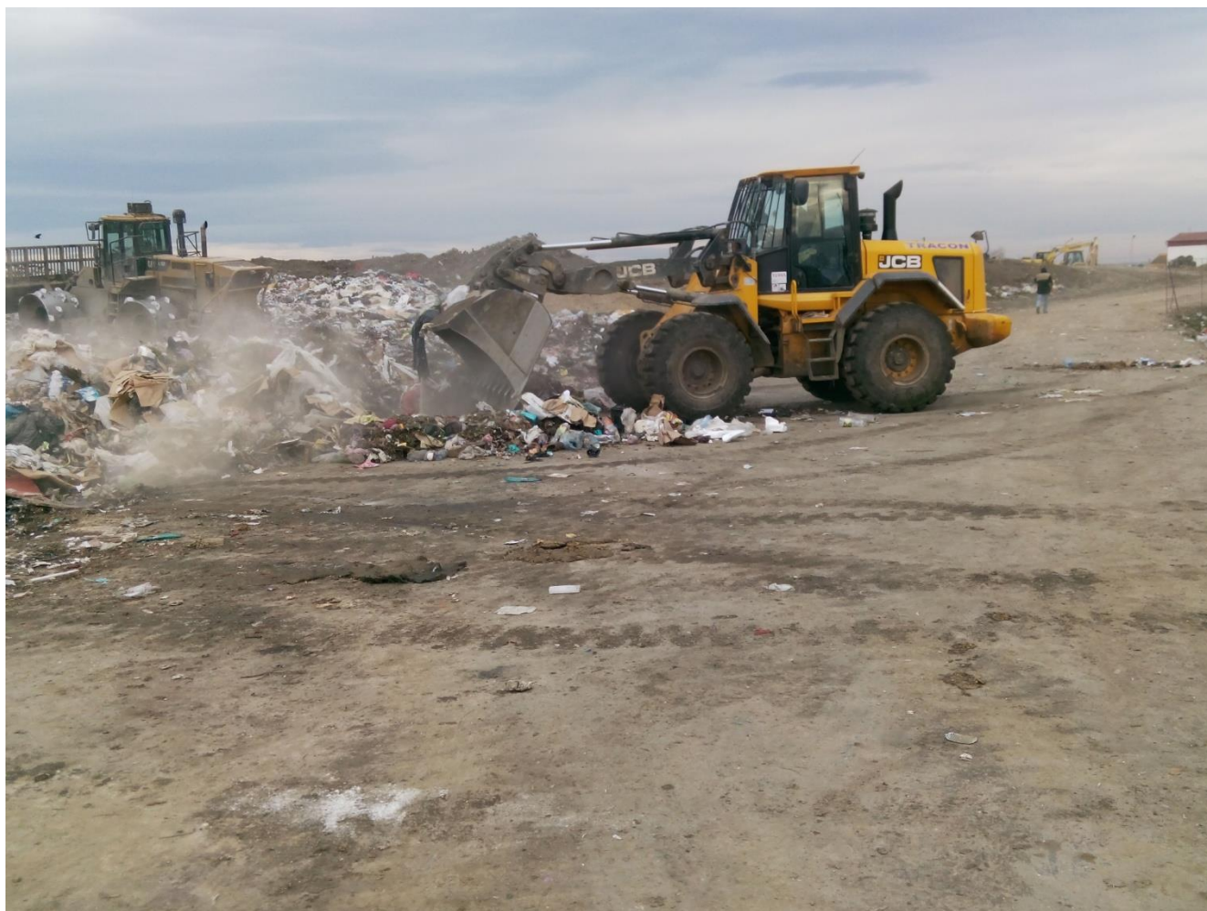
Fig.15 - Platforma pentru descarcarea deseurilor – celula II
