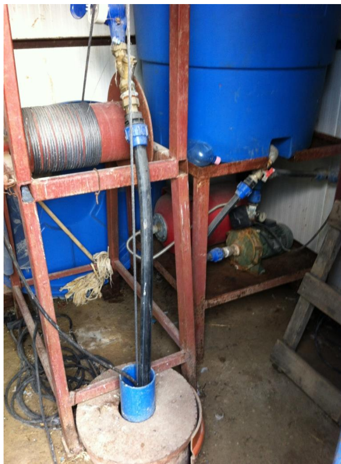
Fig. 6 - Puț pentru alimentare cu apa
