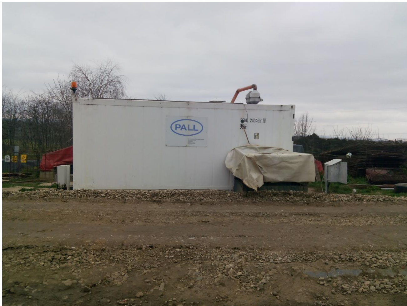
Fig.20 - Statie de epurare monobloc, cu osmoza inversa
