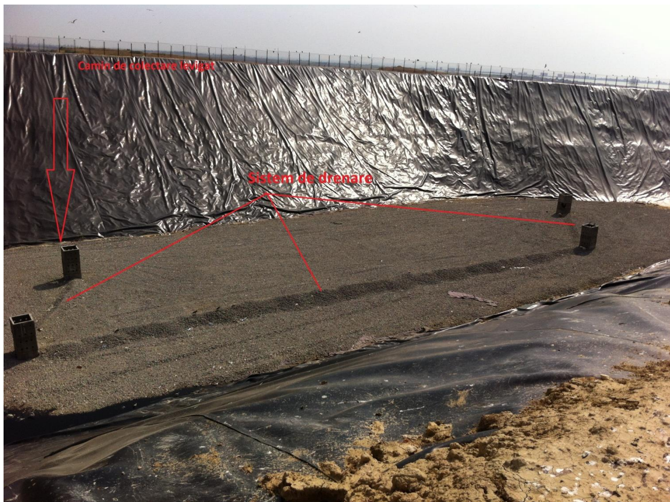
Fig.13 - Sistem de drenare si colectare levigat
