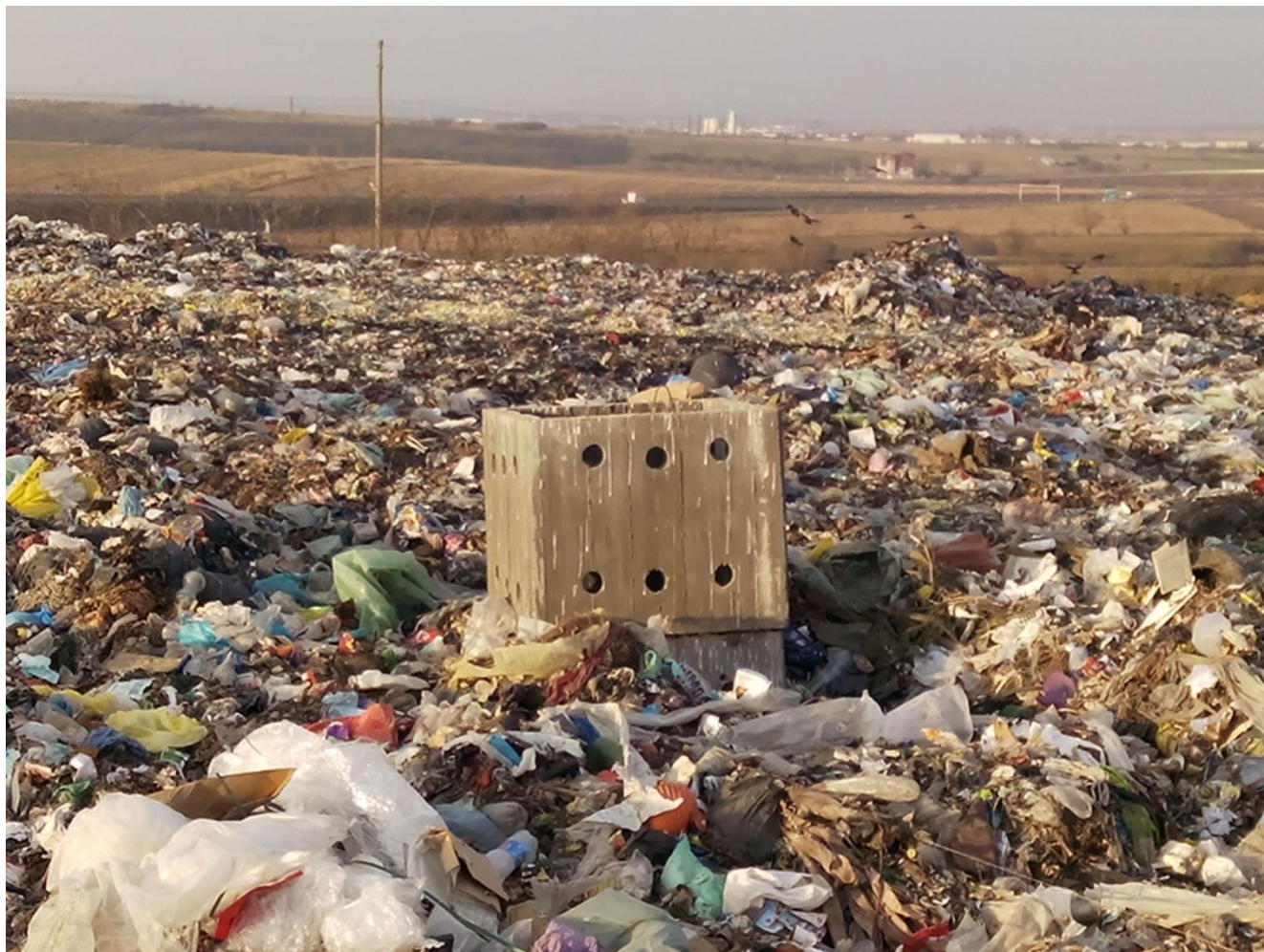
Fig.20 - Puț pentru evacuarea gazului de depozit
